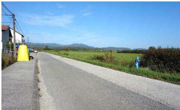
Slika 7. Pogled niz Mostarsku ulicu – spoj na Soblinečku
